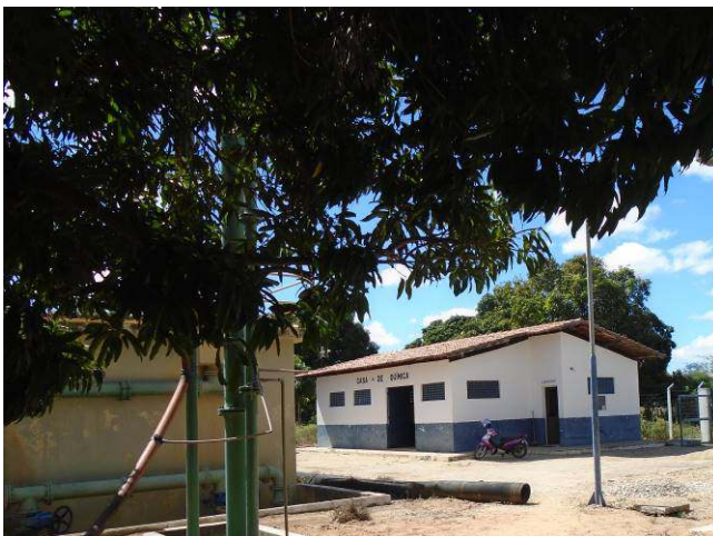
Foto 23 – Casa de Química - ETA
