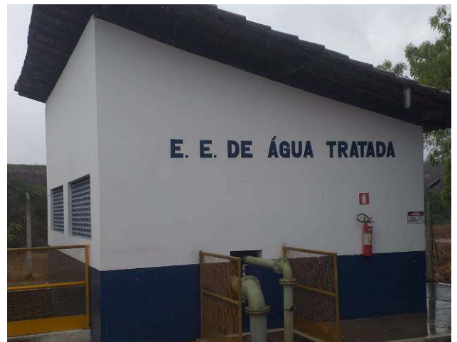
Foto 24 – Estação Elevat. de Água Tratada – ETA
