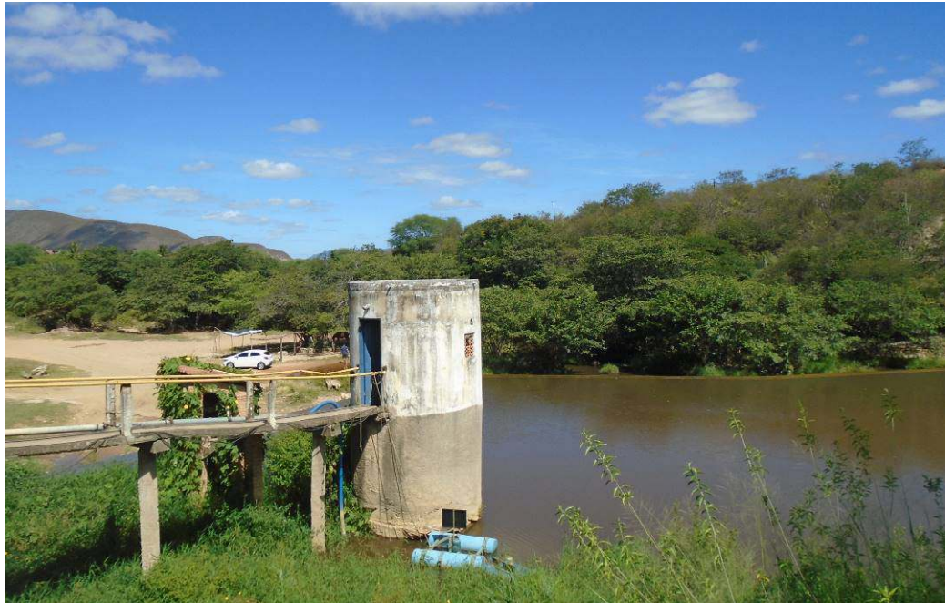
Foto 18 - Captação na Barragem da Perereca
