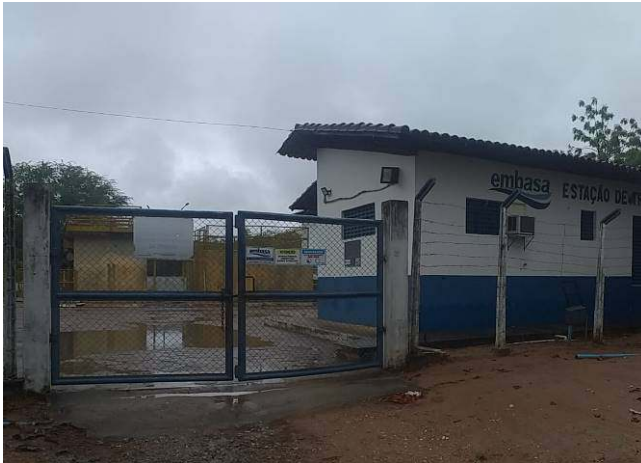
Foto 19 – ETA de Contendas do Sincorá
