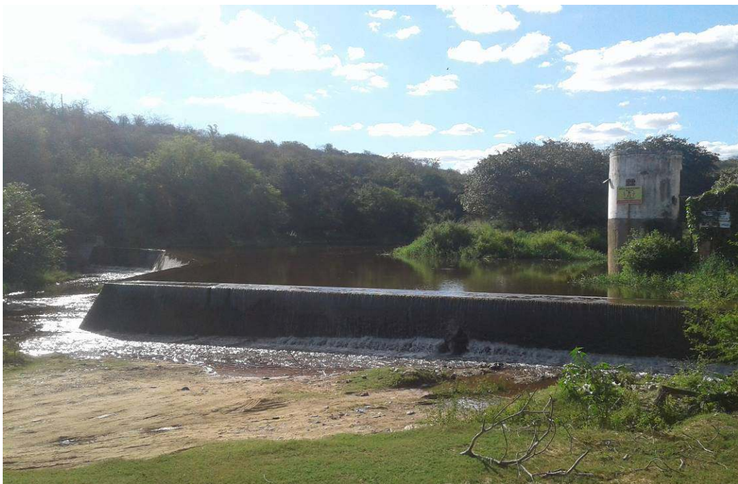
Foto 17 - Barragem da Perereca – Rio Sincorá
