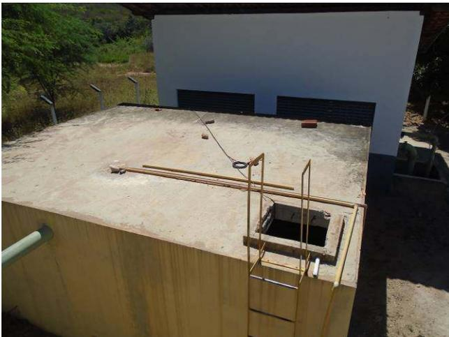
**Foto 21 – Tanque de contato**
